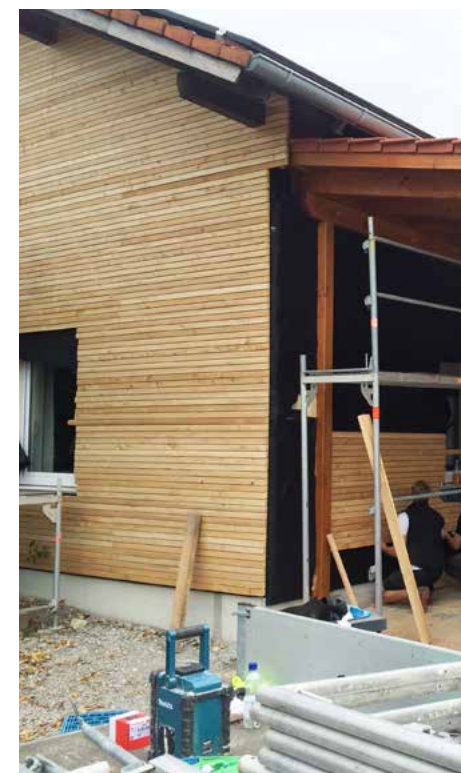
Fertigstellung der Fassade des Musikerheims 2014
